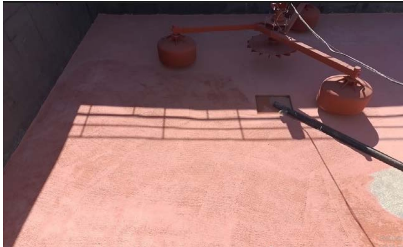
Слика 44. Аератор у SBR 2 реактору (аутор)
