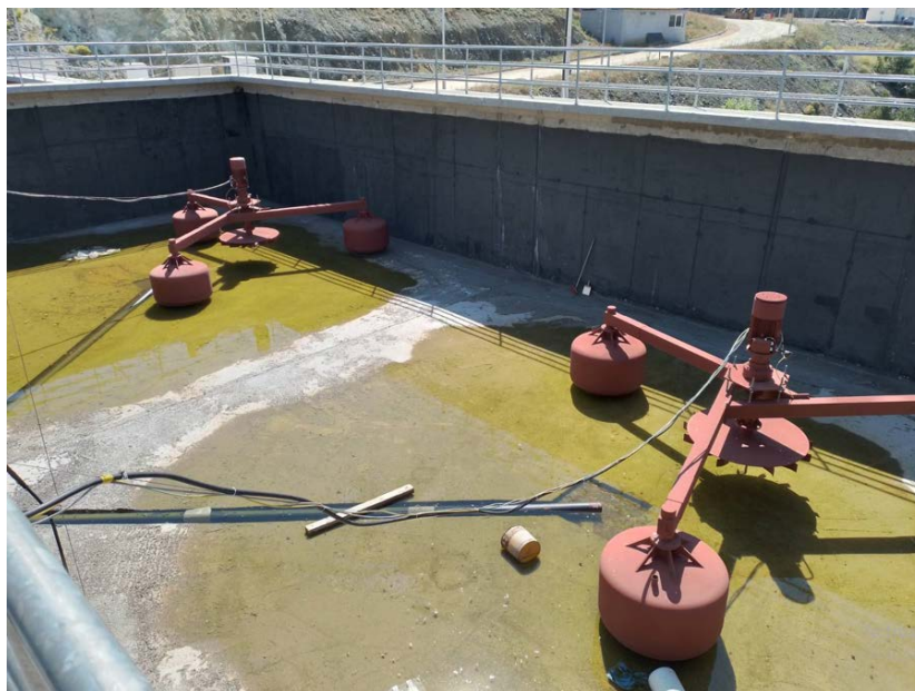
Слика 43. Аератори у SBR 1 реактору (аутор)
